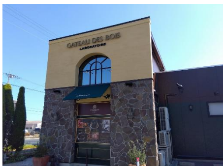
店舗外壁塗装工事
