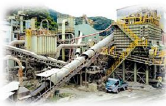
プラントで砕石・砕砂を生産
