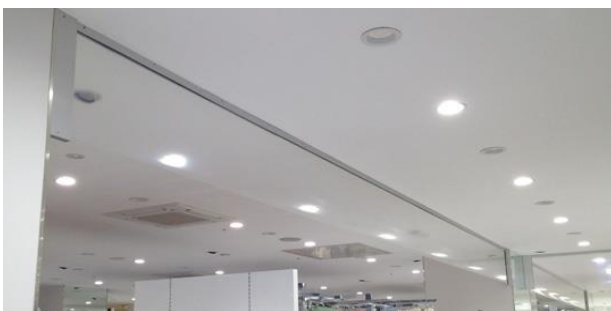
テンションタイプ施工例
