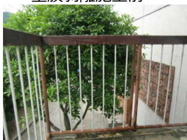
塗膜剥離施工前
