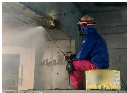
超高压洗浄工事の様子
