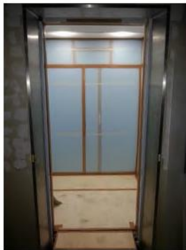
養生工事施工後
