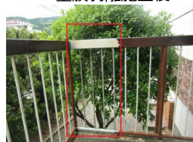
塗膜剥離施工後
